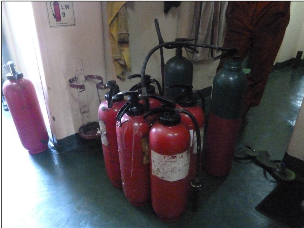
Gambar I-9: Tabung APAR jenis foam dan CO 2 yang digunakan dalam proses pemadaman
