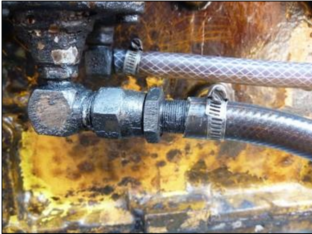
Gambar II-2: Klem dan slang PVC fleksibel pada genset tambahan no.3
