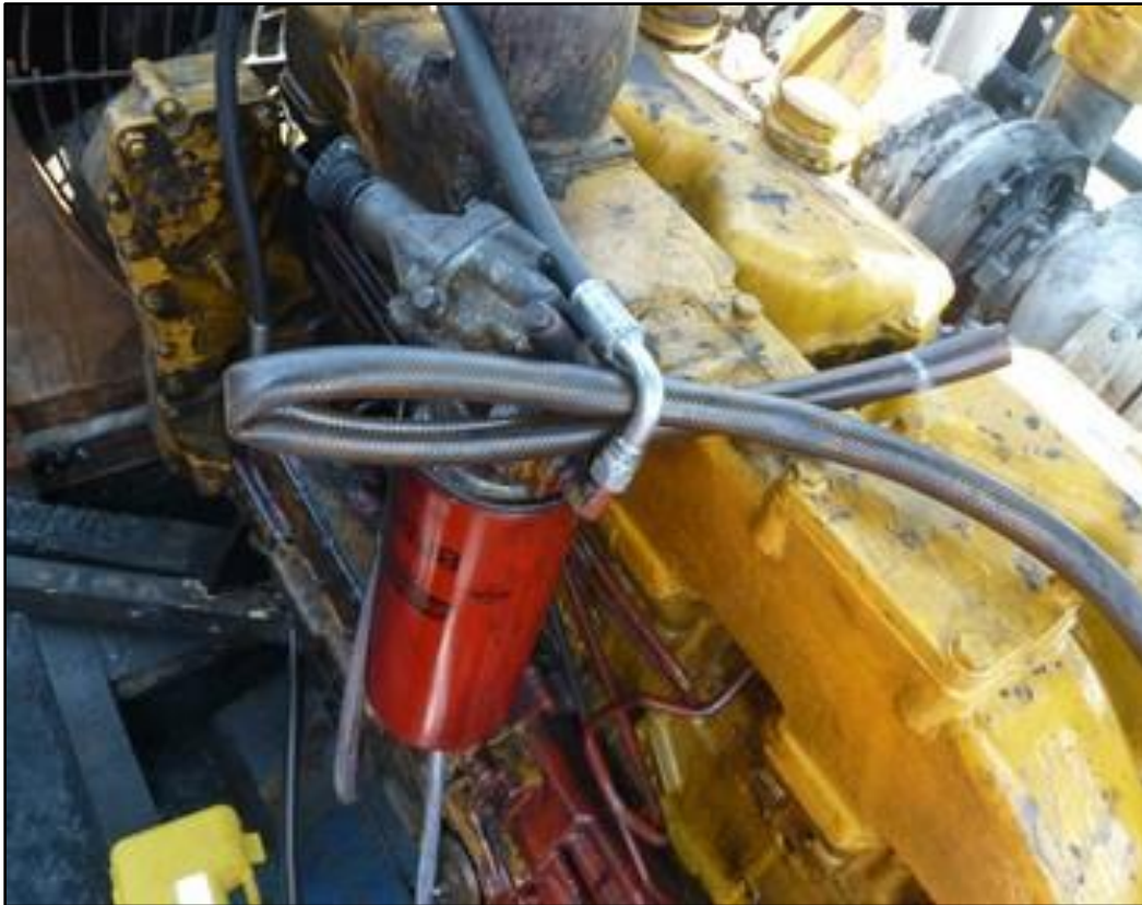
Gambar II-3: Kondisi slang pada genset tambahan no. 3 yang digunakan sebagai suplai bahan bakar
