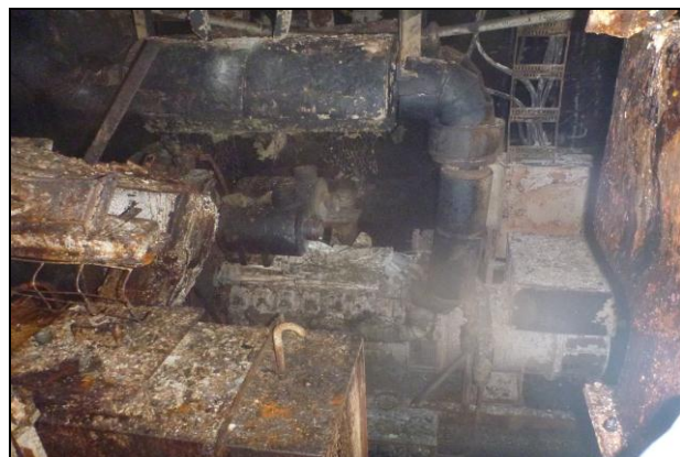
Gambar I-6: Kondisi mesin emergency generator setelah terbakar
