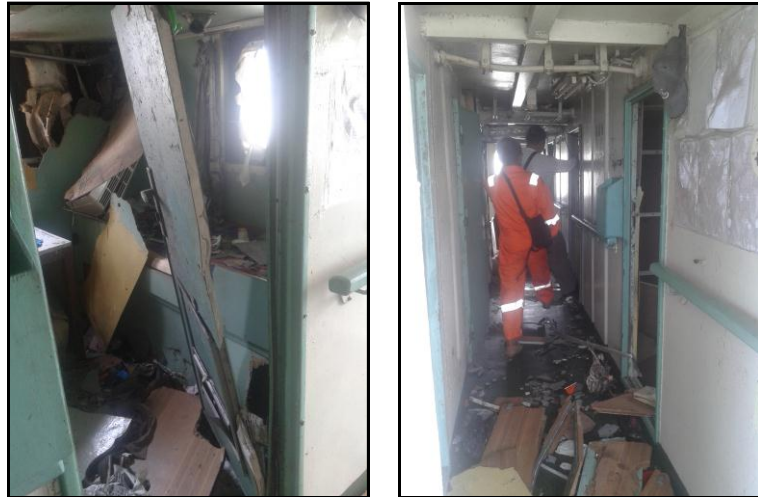
Gambar I-1: Kondisi ruang akomodasi bawahan (rating) Kanan: Gang akomodasi poop deck
