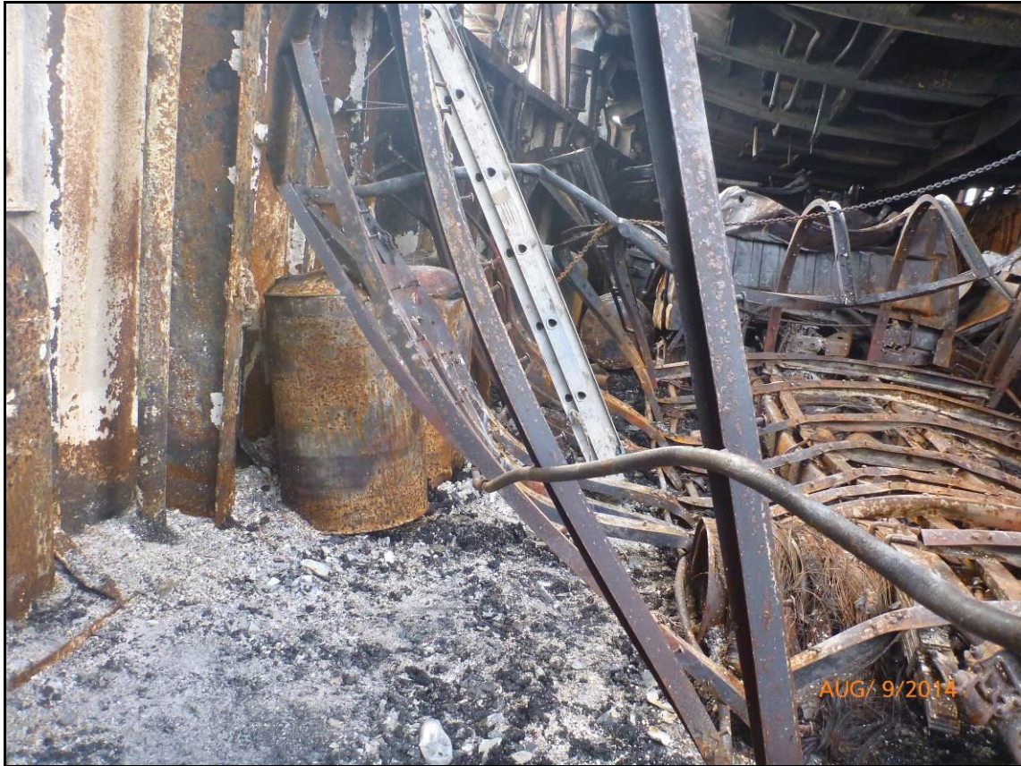
Gambar I-7: Kondisi geladak kendaraan
