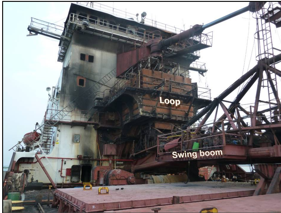
Gambar I-8. Kerusakan di sekitar ruang loop dan swing boom
