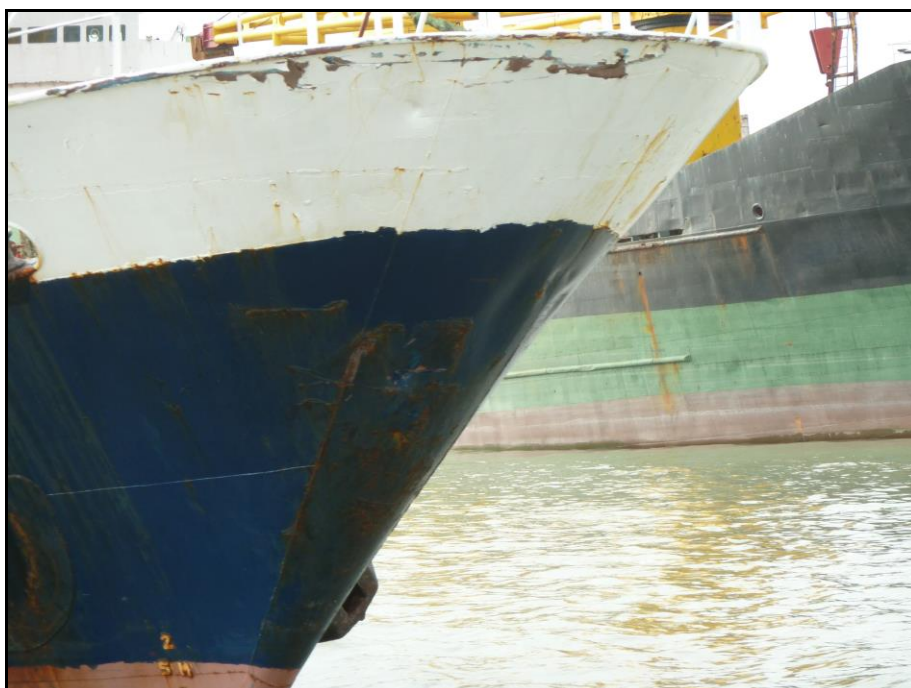
Gambar II-4: Kerusakan ringan pada bagian sheer haluan KM. Alken Pesat
