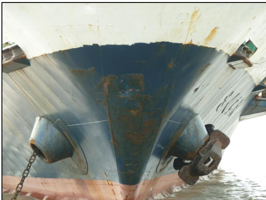
Gambar II-3: Kerusakan ringan pada bagian linggi haluan KM. Alken Pesat
