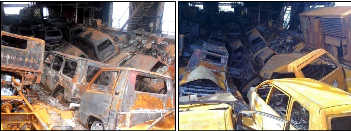
Gambar II-4: Kerusakan konstruksi Upper car deck yang mengalami deformasi akibat paparan panas dari bagian bawah.
