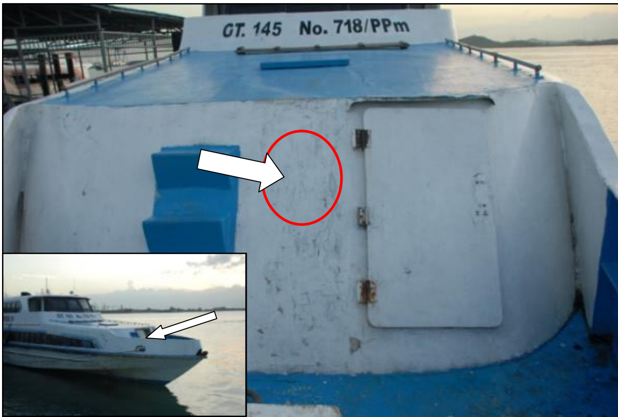
Gambar II-1 Posisi dan sketsa kerusakan berdasarkan keterangan dari tim penyelam
