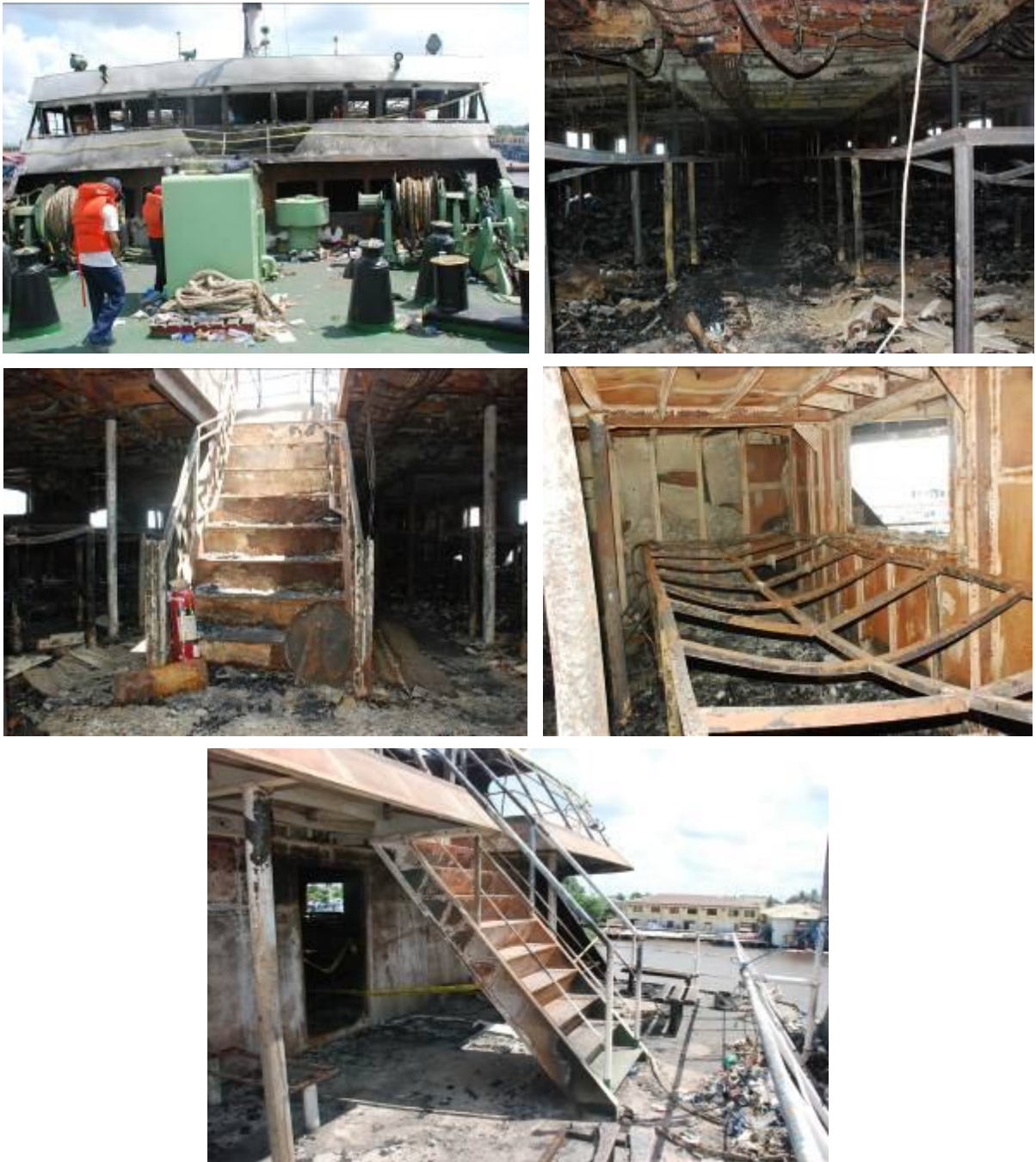
Gambar II-4 kondisi anjungan dan ruang akomodasi penumpang setelah kebakaran
