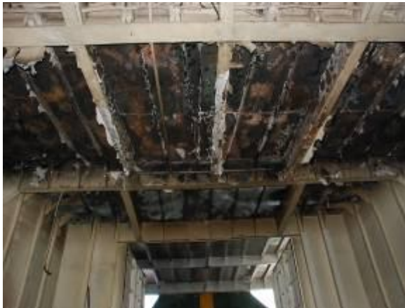
Gambar II-2 Kondisi atap cardeck dan dinding akibat kebakaran
