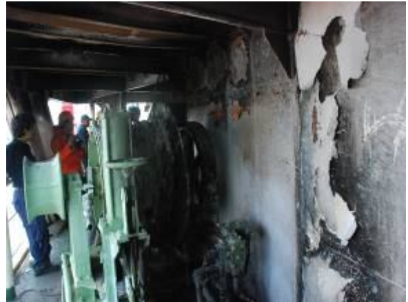
Gambar II-2 Kondisi atap cardeck dan dinding akibat kebakaran
