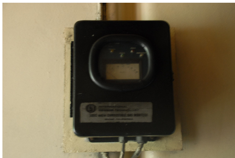
Gambar II-3 gas detector yang terpasang pada gang akomodasi
