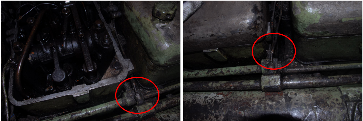
Gambar II-2 Penambalan pada pipa
