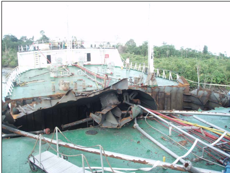
Gambar I-3 kerusakan di geladak MT.Maulana akibat ledakan
