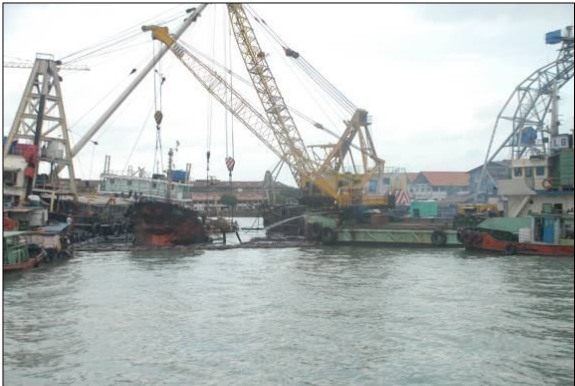
Gambar I-9 penggunaan crane apung untuk menahan posisi kapal
