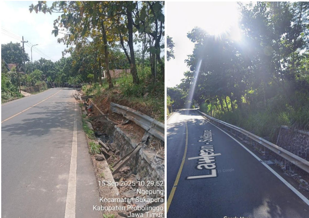
Gambar 15. rambu peringatan tikungan roboh akibat ditabrak mobil bus (foto kanan sumber : Google Map 2025)
