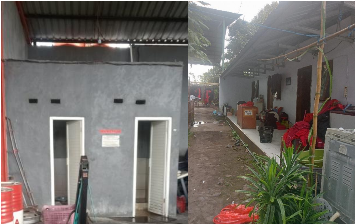
Gambar 21. Kondisi toilet (kiri) dan laundry (kanan) untuk pengemudi
