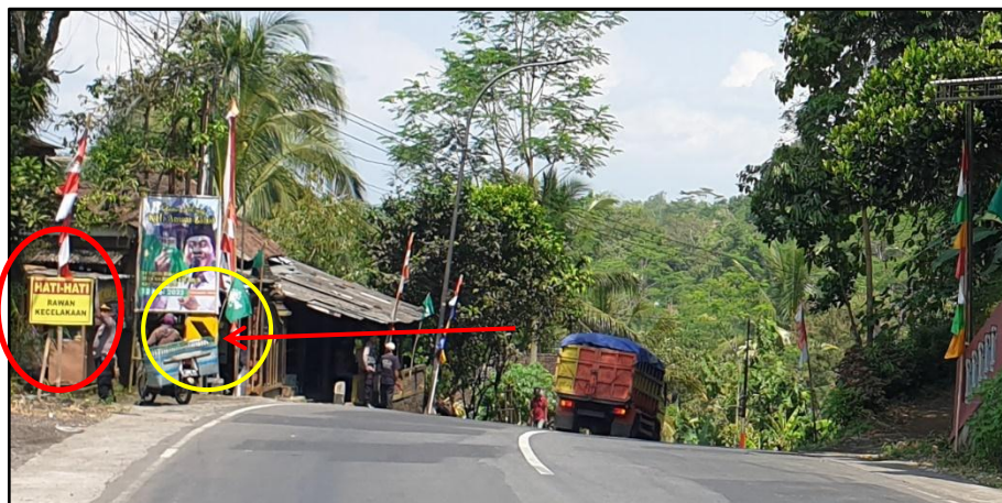
Gambar 20. Banner peringatan hati-hati rawan kecelakaan dan rambu Chevron sekitar 20 meter sebelum lokasi kecelakaan
