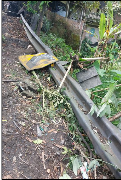
Gambar 21. Pagar pengaman/guardrail di tikungan
