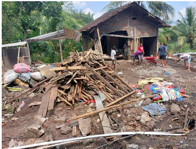
Gambar 11. Kerusakan bangunan permanen
