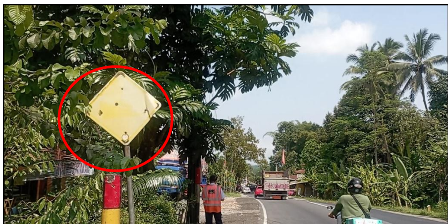
Gambar 17. Rambu peringatan jalan menurun kondisi hilang gambarnya, sekitar 180 meter sebelum lokasi kecelakaan
