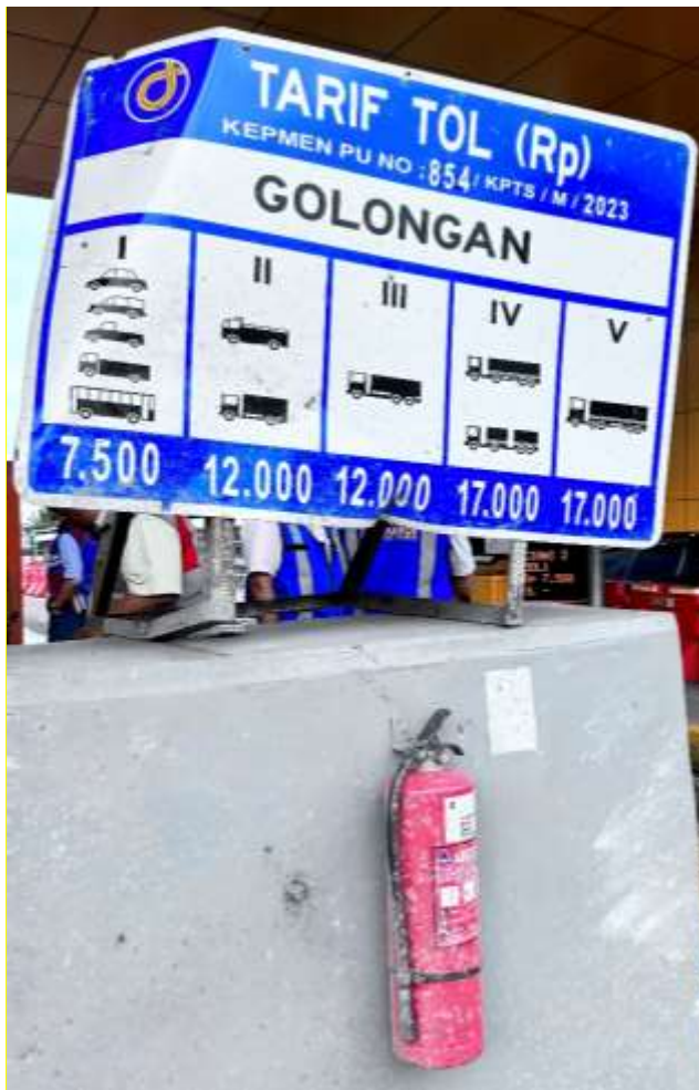
Gambar 43. Kondisi APAR yang berada pada setiap gerbang tol
