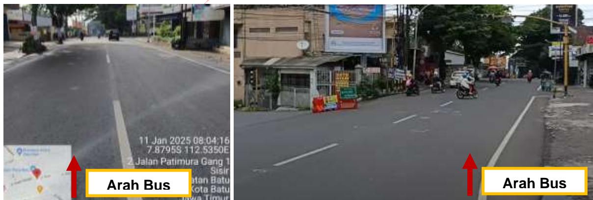
Gambar 25. Kondisi Jalan Pattimura
