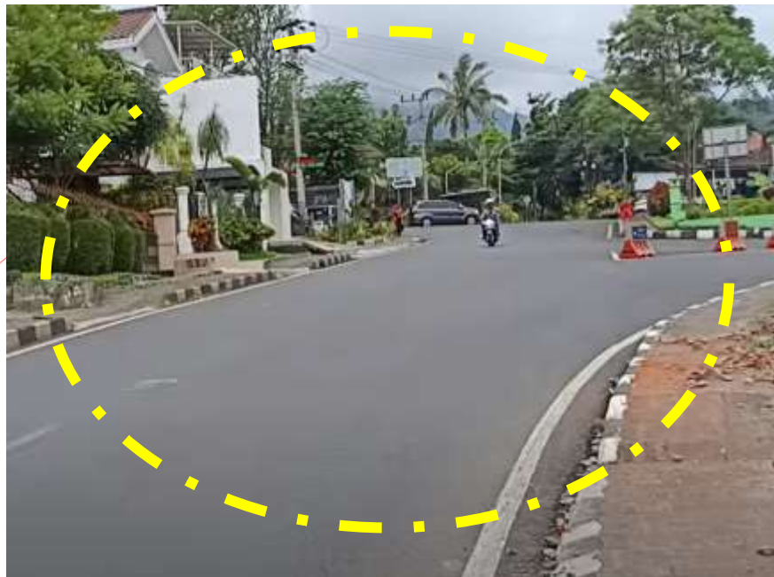
Gambar 32. Area tidak terdapat Marka Jalan dan Batasan Ruang Kendaraan
