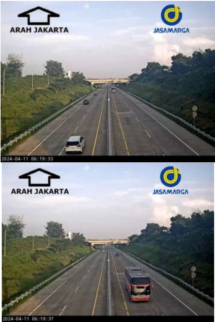
Gambar 19. Hasil pemeriksaan rekaman video cctv jalan tol Sumber: PT Jasa Marga (Persero) diolah KNKT
