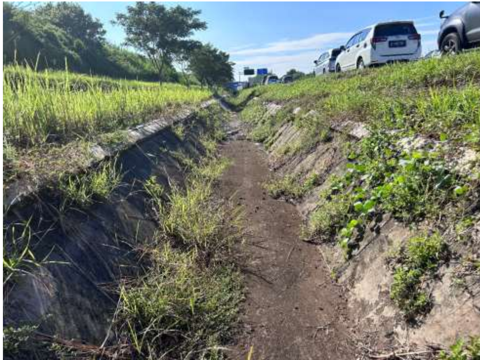
Gambar 12. Drainase / saluran samping jalan tol dengan lebar 2 meter dan kedalaman 0,7 meter
