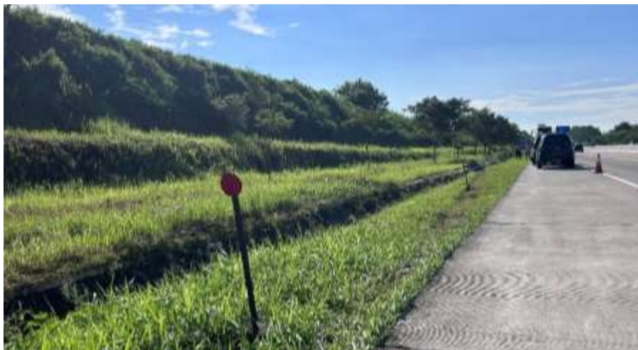
Gambar 13. Drainase / saluran samping menerus jalan tol
