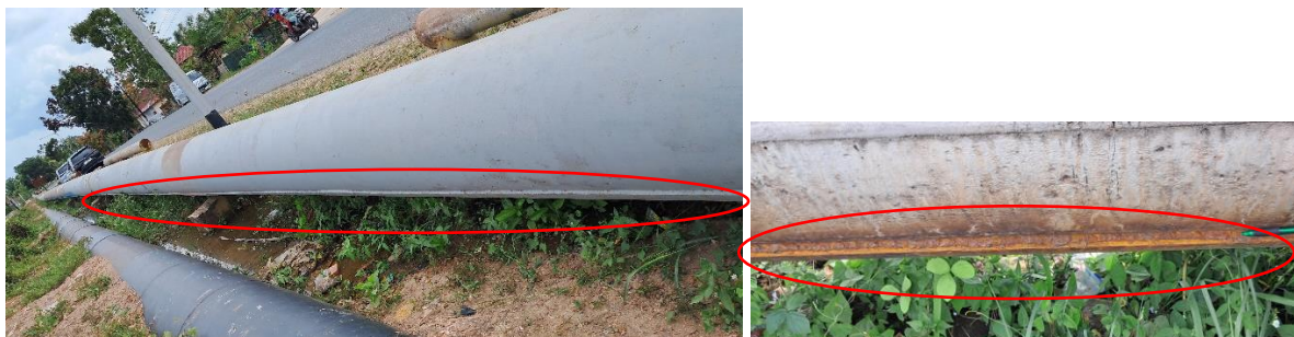
Gambar 32. Foto Perbaikan Dengan Menambal Area Bawah Pipa Air Dengan Dilakukan Pengelasan
