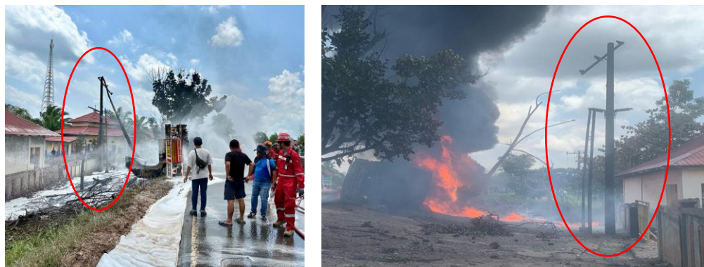
Gambar 18. Dampak Kebakaran Terbakarnya Tiang Listrik dan Terputusnya Kabel Jaringan Listrik
