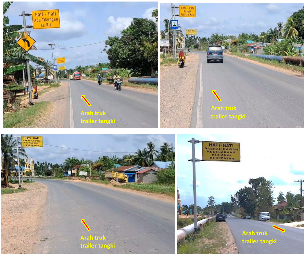
Gambar 10. Rambu Peringatan di Sekitar Lokasi Kejadian
