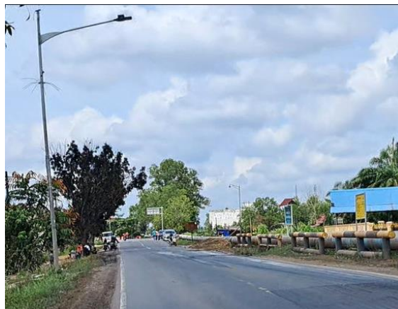
Gambar 11. Lampu Penerangan Jalan Umum
