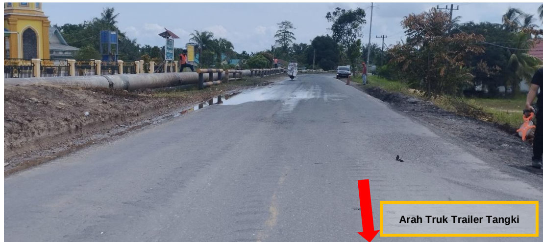
Gambar 5. Kondisi Jalan di Lokasi Kejadian Kecelakaan
