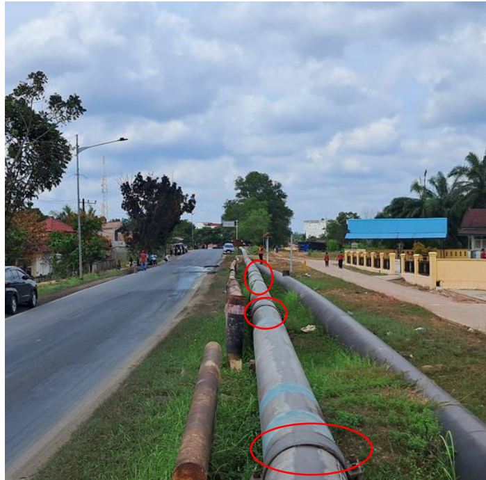
Gambar 30. Pada Jarak Sekitar 100 M Sebelum dan Setelah Lokasi Kejadian Terdapat Tambalan Lebih Dari 15 Titik Tambalan Pada Pipa Air
