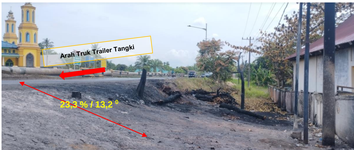
Gambar 8. Kemiringan Bahu Jalan
