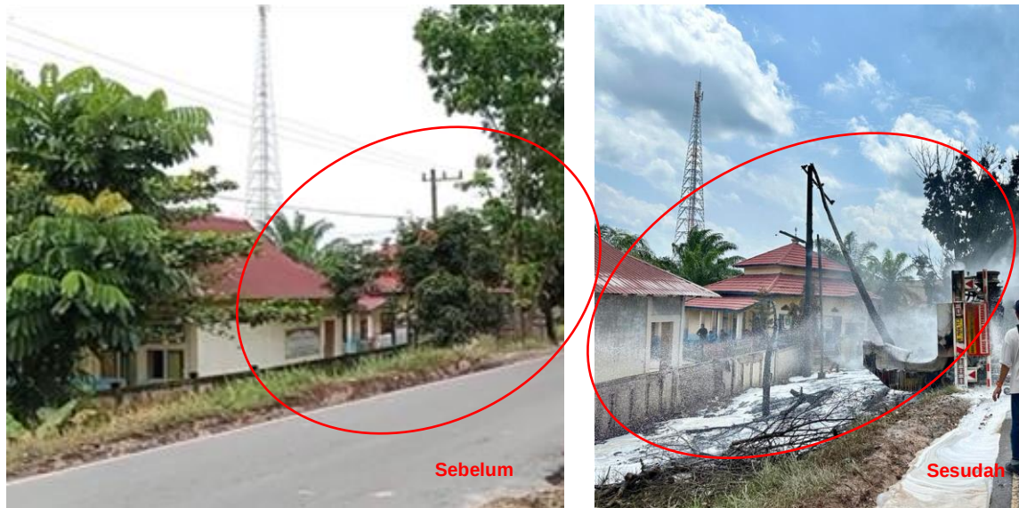
Gambar 19. Terbakarnya Beberapa Pohon Yang Berada Pada Sisi Bahu Jalan dan Pagar Sekolah
