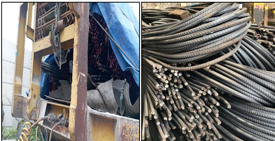
Gambar 22. Muatan truk trailer besi beton ulir CBS uk. 16 mm sebanyak 2.641 batang
