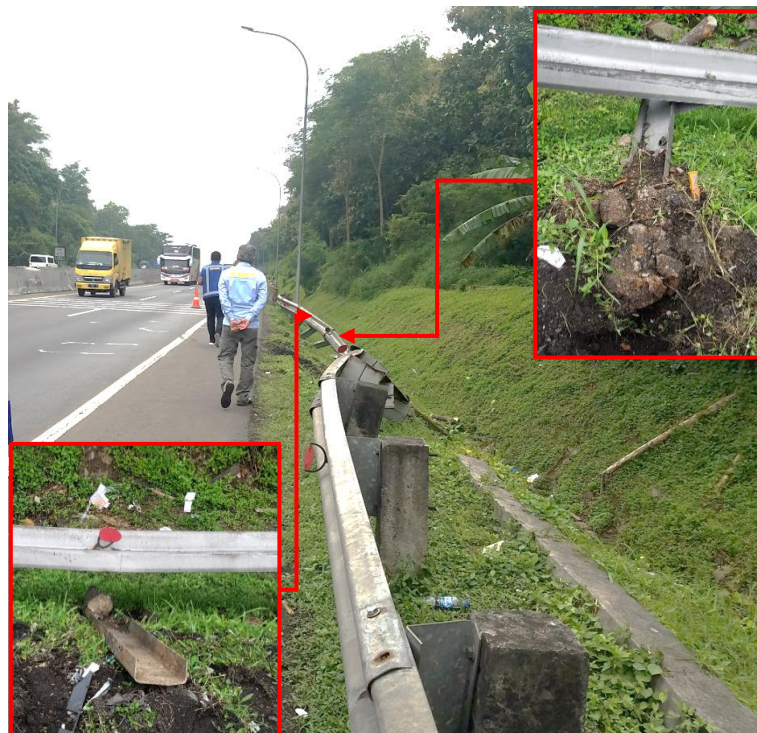
Gambar 7. Kerusakan guardrail
