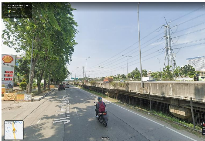
Gambar 15. Kondisi jalan arteri samping jalan tol yang dipisahkan pagar pengaman. (Sumber: Google Maps diakses 28 November 2022)
