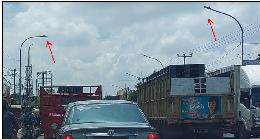
Gambar 8. Terpasang Lampu Penerang Jalan di kedua jalur
