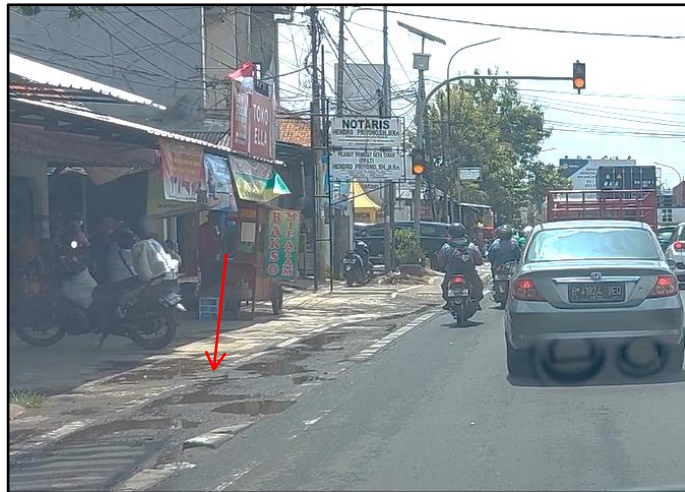
Gambar 12. Tidak ada bahu jalan dan trotoar paving blok
