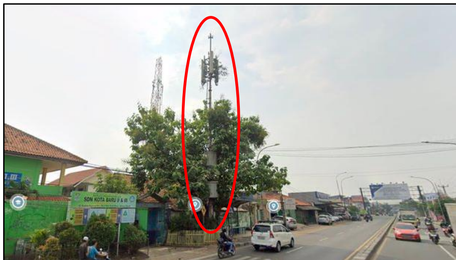
Gambar 13. Tiang BTS sebelum roboh ditabrak truk trailer
