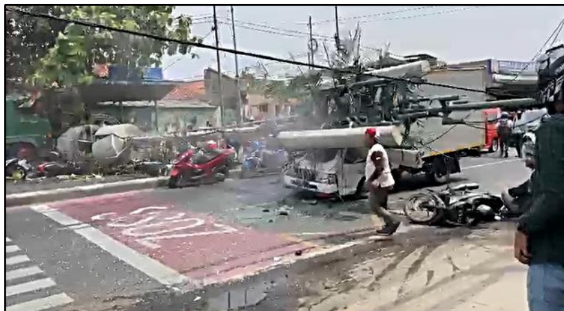
Gambar 3. Tiang BTS yang roboh setelah tertabrak truk trailer
