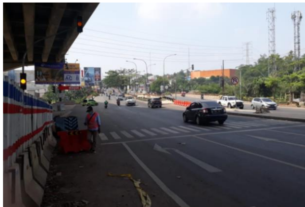
Gambar 14. Terpasang APILL CBD
