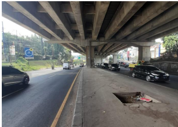
Gambar 8. Kondisi prasarana jalan lokasi kejadian kecelakaan di bawah jalan Tol Layang Cimanggis-Cibitung
