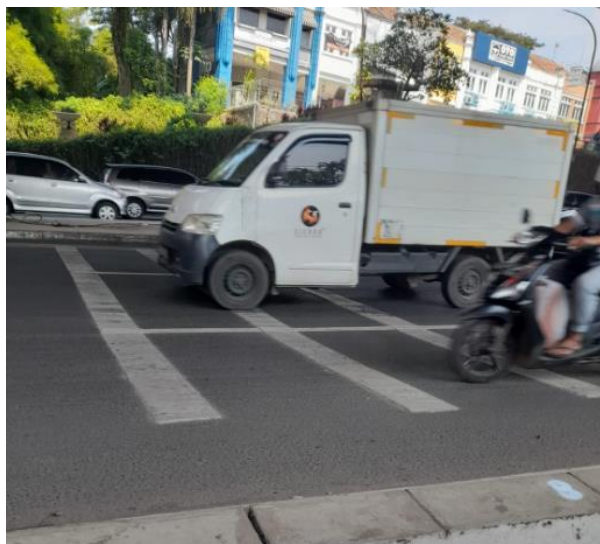
Gambar 9. Rumble Strip pada jalan turunan 300 meter sebelum APILL CBD
