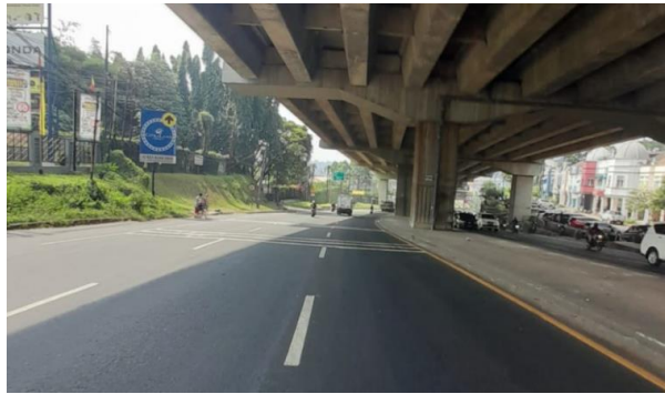
Gambar 15. Posisi APILL CBD terhalang pilar penyangga jalan Tol Layang Cimanggis-Cibitung
