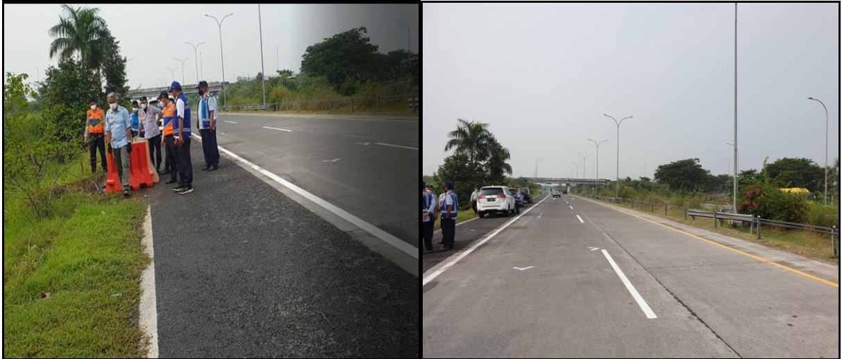
Gambar 11. Kondisi ruas jalan Tol Surabaya Mojokerto Km 712 +400
