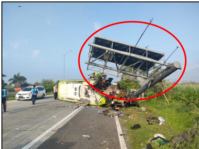
Gambar 8. Kondisi VMS yang tertabrak oleh bus wisata
