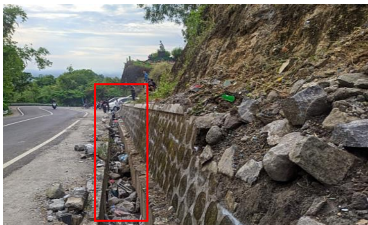
Gambar 18. Drainase terbuka tinggi ± 70 cm.
