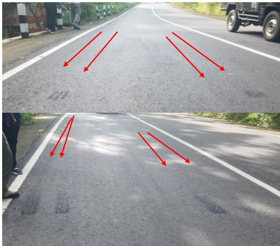
Gambar 23. Skid Marks rem di jalur lawan ± 200 meter sebelum lokasi kecelakaan
