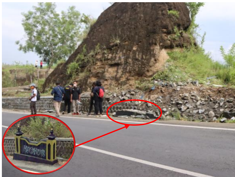
Gambar 15. Pagar beton dan talud batu kali ditabrak bus wisata
