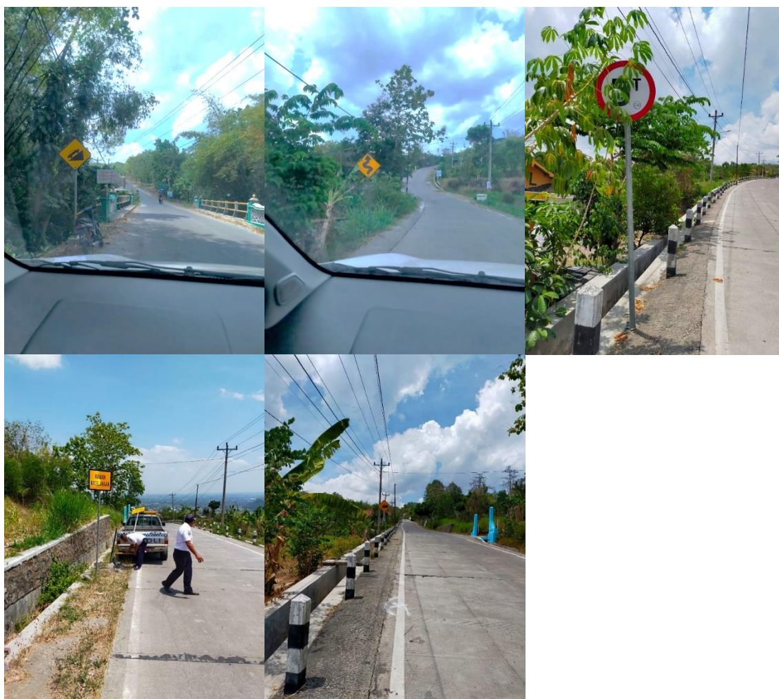
Gambar 8. Perlengkapan Jalan di lokasi
