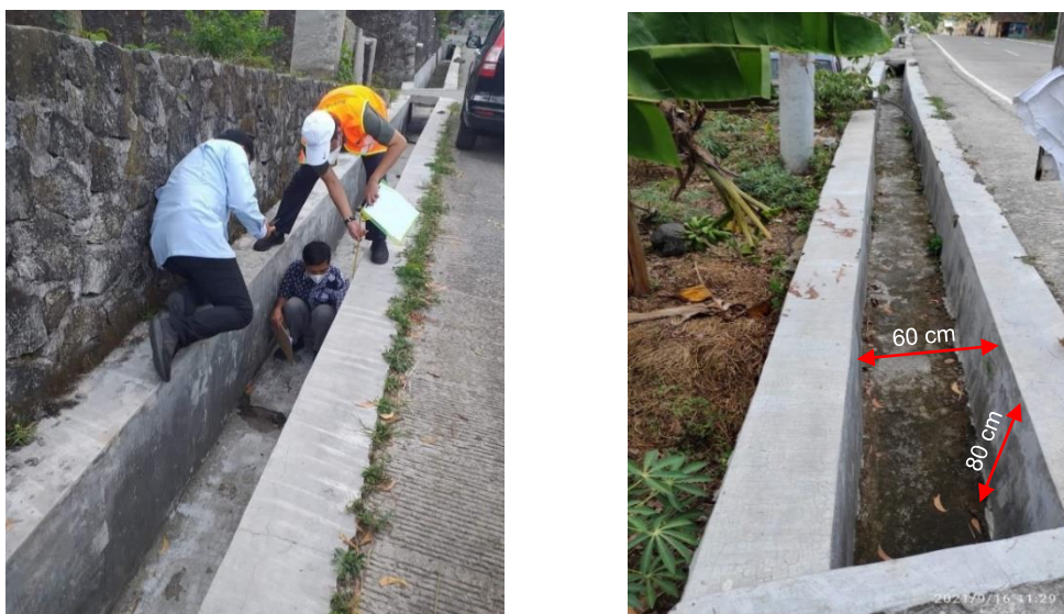
Gambar 7. Drainase terbuka lebar 60 cm dan kedalaman 80 cm
