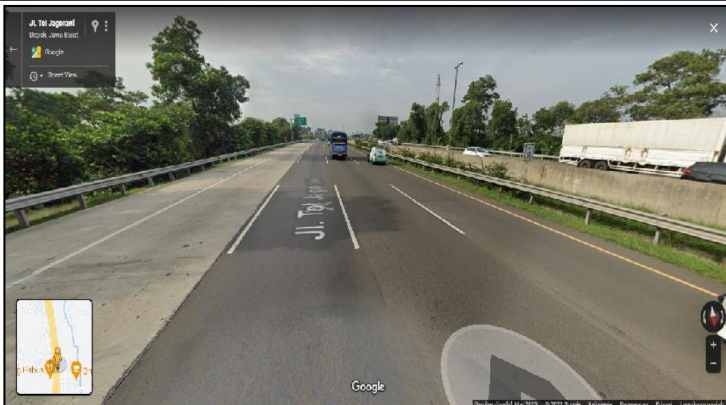
Gambar 8. Kondisi ruas jalan tol Jagorawi Km. 18
