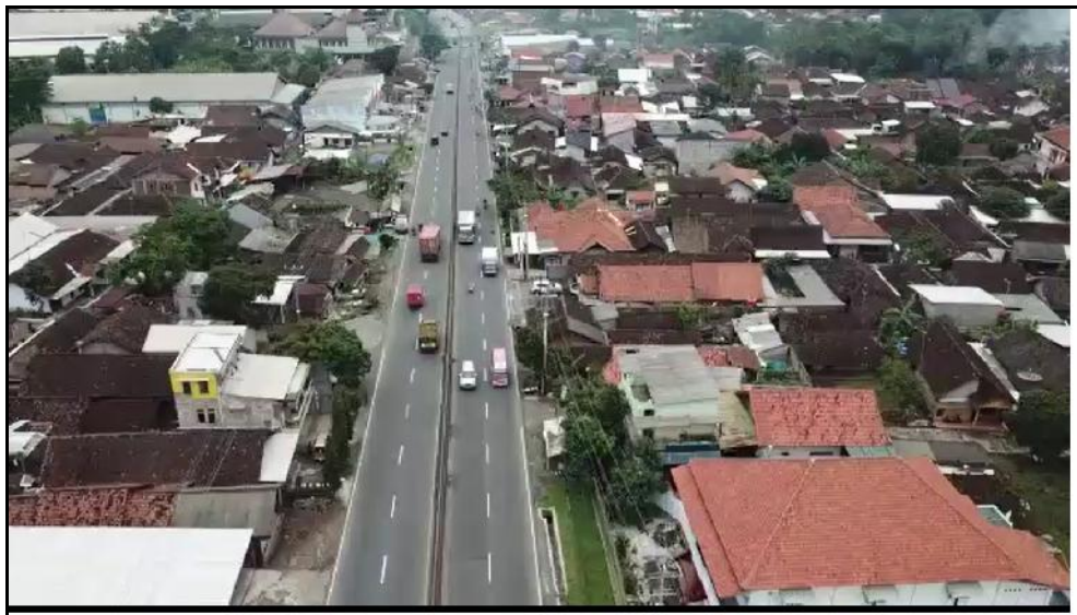
Gambar 14. Kondisi ruas jalan Soekarno-Hatta ( \pm 600 meter sebelum lokasi kejadian)
