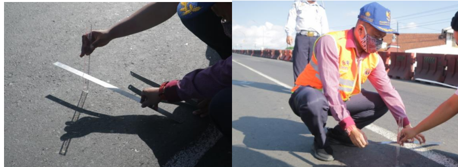
Gambar 9. Pengukuran Perbedaan Ketinggian Permukaan Jalan
