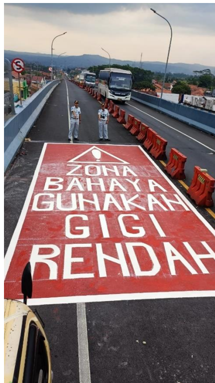
Gambar 20. Pemasangan Marka Zona Berbahaya oleh PT Jasa Raharja
