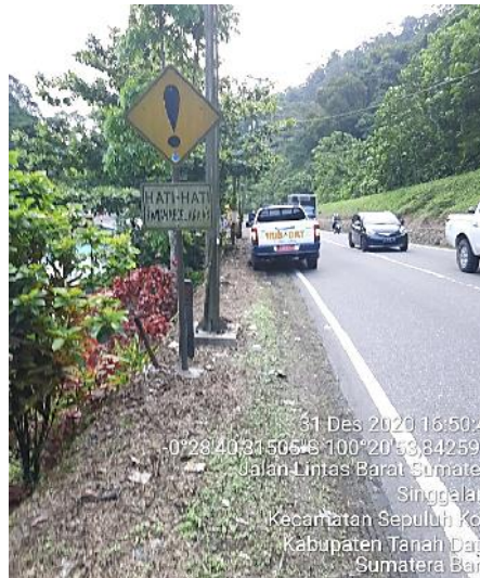
Gambar 11. Rambu peringatan daerah rawan kecelakaan 2 km dari lokasi kecelakaan
