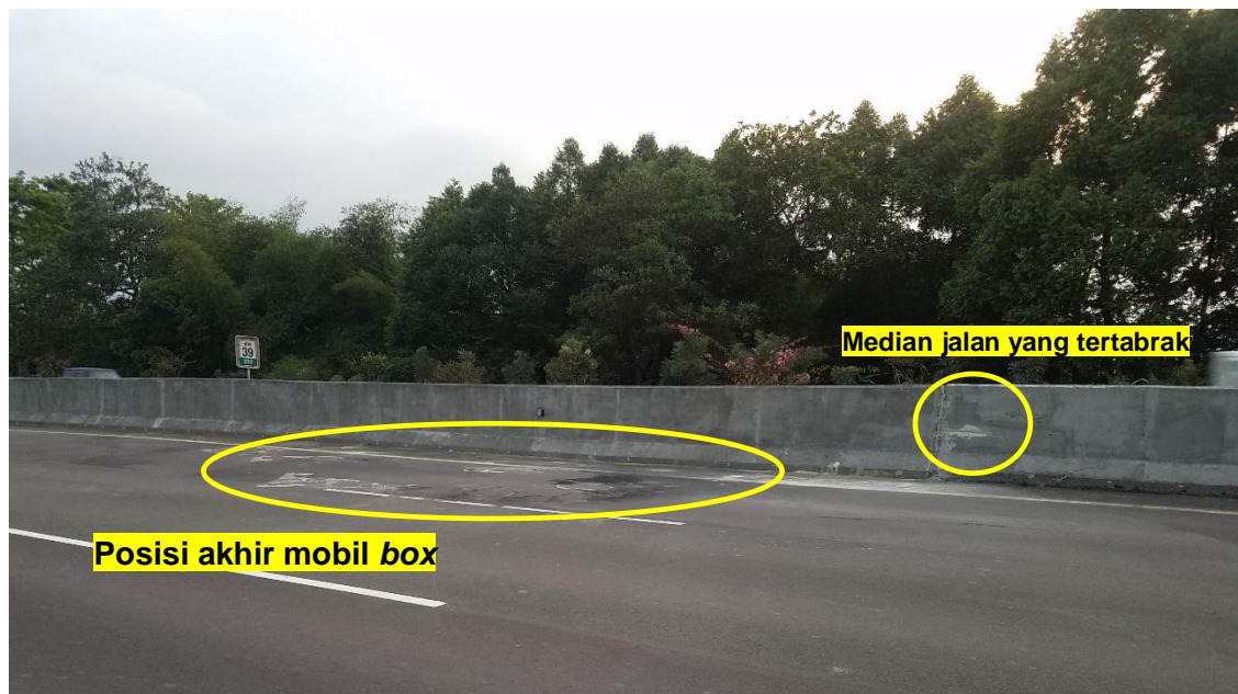
Gambar 3. Kerusakan pada jalan tol dan kelengkapannya.
