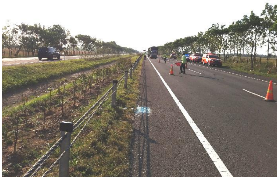
Gambar 15. Wire rope pada median jalan sepanjang 35,174 km
