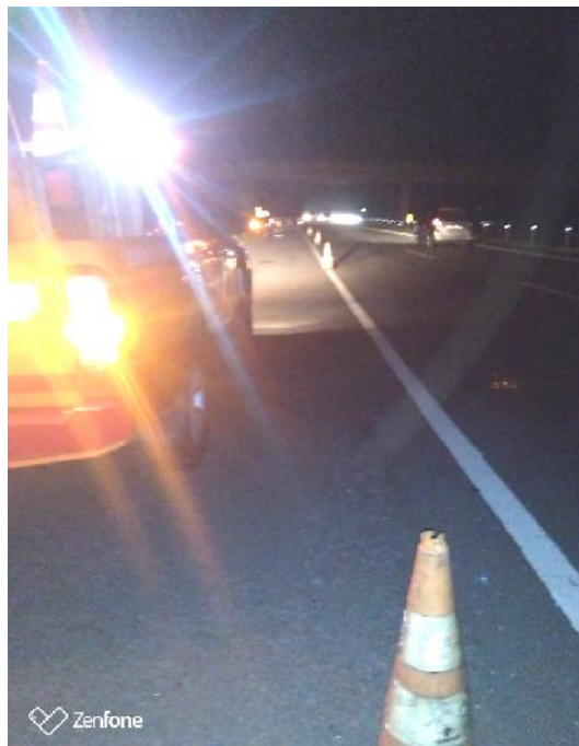
Gambar 17. Traffic cone terpasang 5 unit berjarak 10 meter per unit
