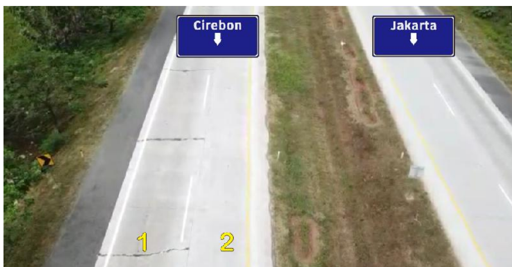
Gambar 10. Jalan Tol Cipali KM 184+300 A
