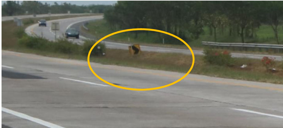
Gambar 8. Rambu Chevron Rusak Setelah Tertabrak Microbus
