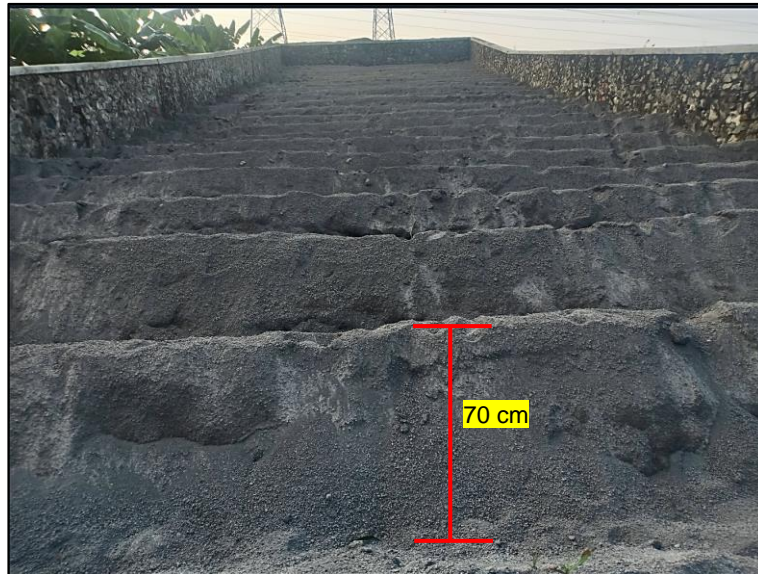
Gambar 15. Material Jalur Penghentian Darurat pasir bergelombang setinggi ± 70 cm dan kondisi pasir sudah padat
