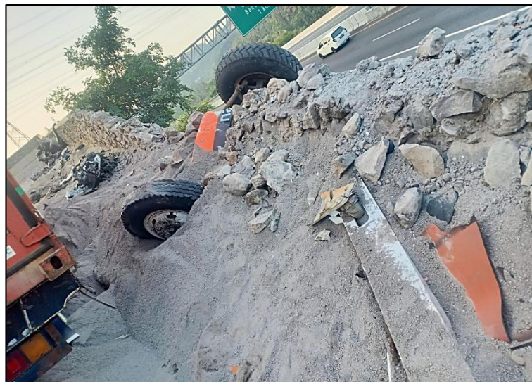
Gambar 9. Pagar Pembatas Jalur Penghentian Darurat sebagian hancur
