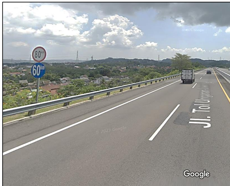
Gambar 12. Terpasang Rambu Peringatan Batas Kecepatan
