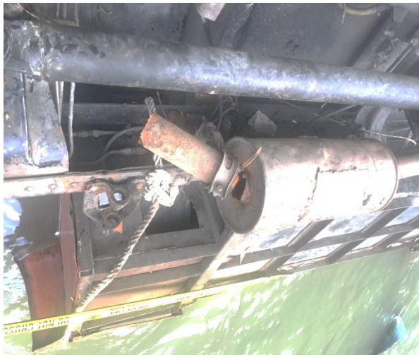
Gambar 8. Valve Exhaust Brake tidak terpasang (tidak ada rem pelambat)
