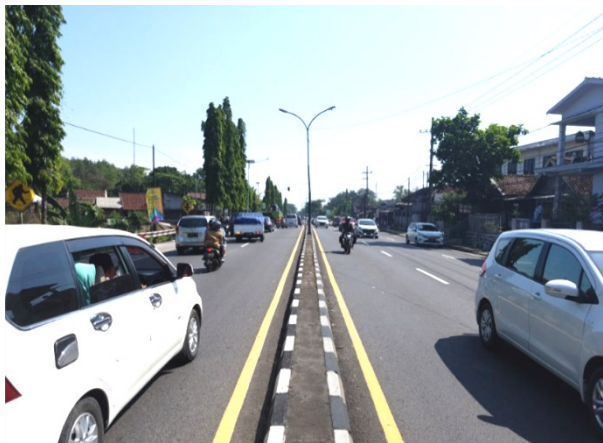
Gambar 18. Jalur arah kecelakaan (arah ke Surabaya) : lalu lintas 2 lajur searah, kondisi marka jelas, rambu peringatan jelas, warning light solar cell tidak fungsi, LPJU fungsi dan terdapat pagar pengaman jalan.
