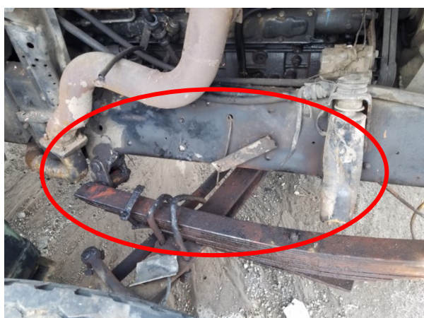
Gambar 9. Suspensi depan kanan rusak akibat tabrak pilar desa
