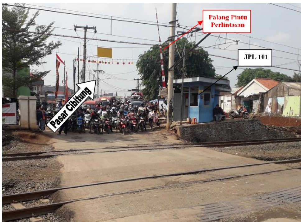
Gambar 7. Palang pintu perlintasan dari arah Pasar Cibitung
