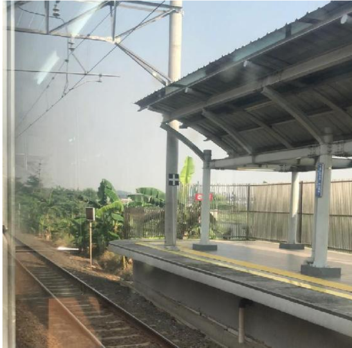
Gambar 12. Semboyan 10G “Marka Batas Berhenti Kereta Api” St. Telaga Murni
