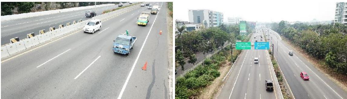
Gambar 14. Kondisi Perlengkapan Jalan di Lokasi Kecelakaan
