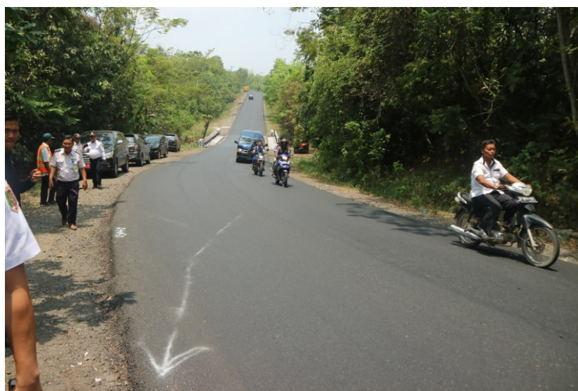
Gambar 8. Lokasi kecelakaan : Permukaan jalan aspal baru tanpa marka, perbedaan tinggi antara bahu dengan badan jalan, lalu lintas 2 jalur tanpa median, tidak dilengkapi rambu-rambu
