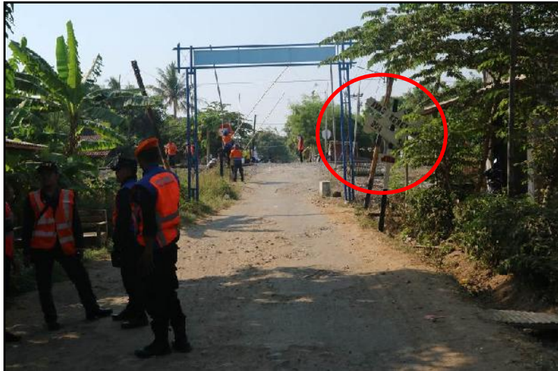
Gambar 22. Kondisi rambu peringatan yang tidak standar dan tertutup pohon.
