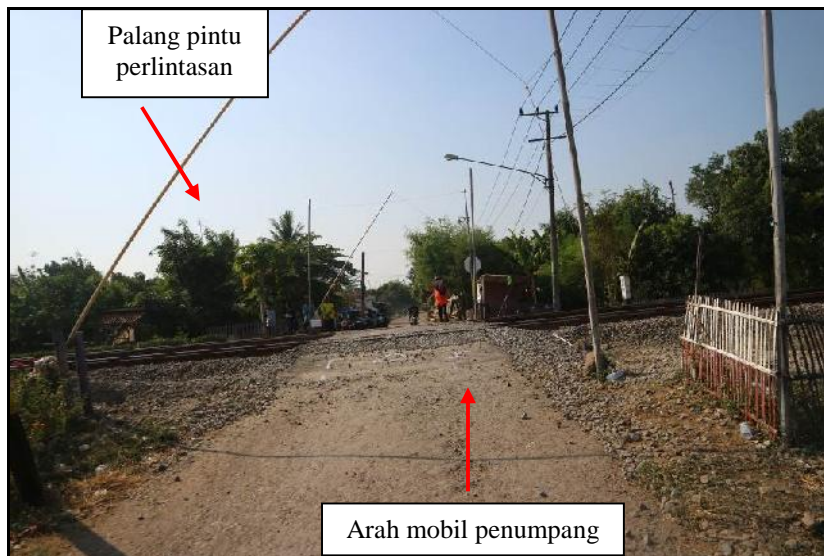
Gambar 15. Kondisi palang pintu perlintasan yang berada di sisi selatan (arah mobil penumpang menuju perlintasan).
