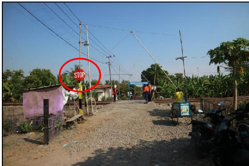
Gambar 26. Kondisi rambu tidak standar dan terletak pada jarak sekitar 5 meter dari perlintasan sebidang.
