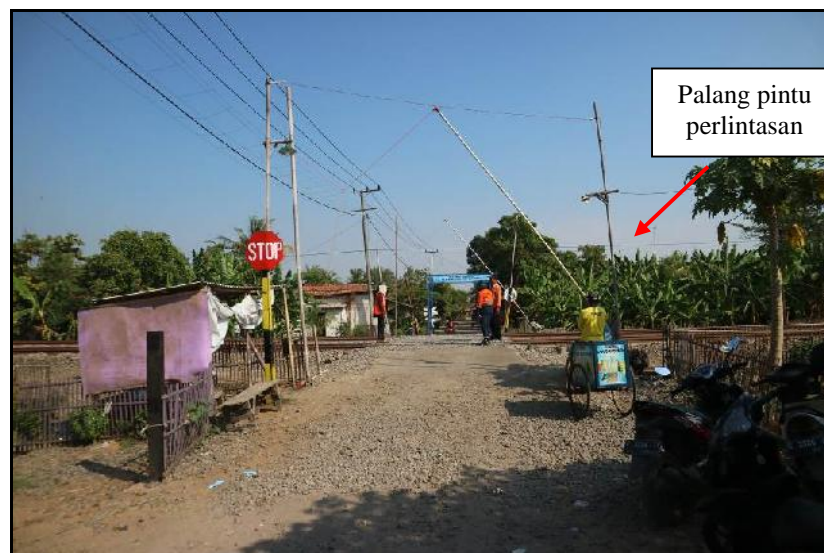
Gambar 16. Kondisi palang pintu perlintasan yang berada di sisi utara (arah sepeda motor menuju perlintasan sebidang).
