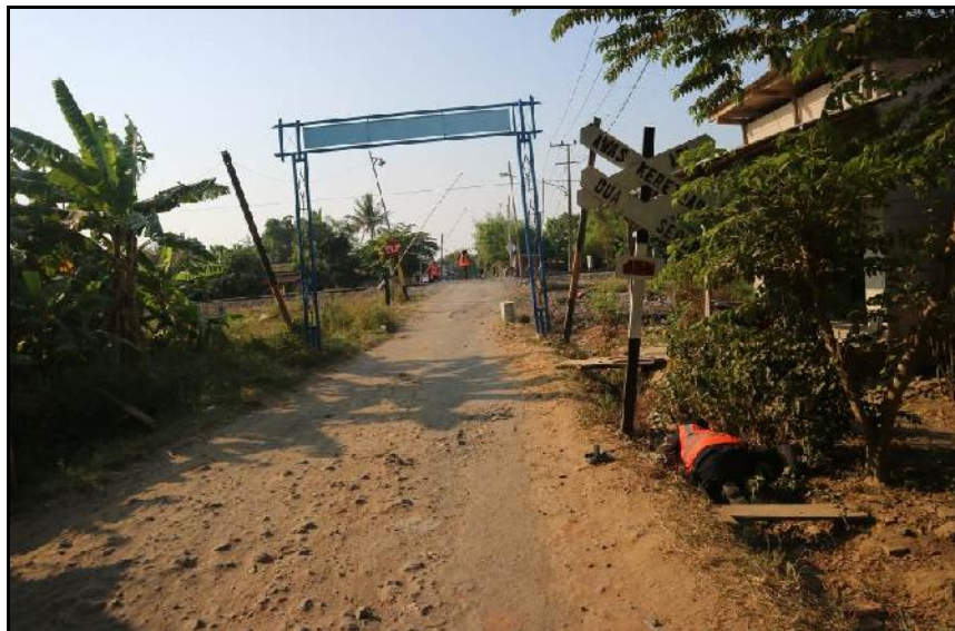
Gambar 24. Ruas jalan PU Mulya (arah mobil penumpang menuju perlintasan sebidang) yang tidak terdapat marka.
