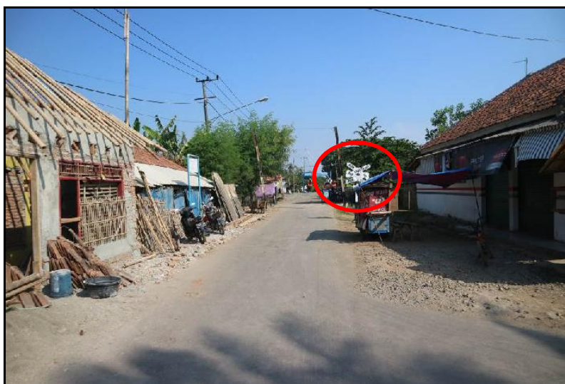
Gambar 25. Kondisi rambu peringatan tidak standar dan tertutup pohon.
