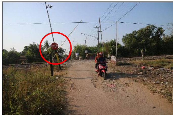
Gambar 23. Kondisi rambu stop yang tidak standar dan terletak pada jarak sekitar 5 meter dari perlintasan sebidang.
