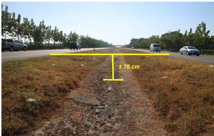
Gambar 8. Jalan Tol Cipali 2 lajur arah ke Cirebon, bermedian tanpa pagar pengaman dan 2 lajur arah ke Cikopo, tidak ada rambu dan informasi
