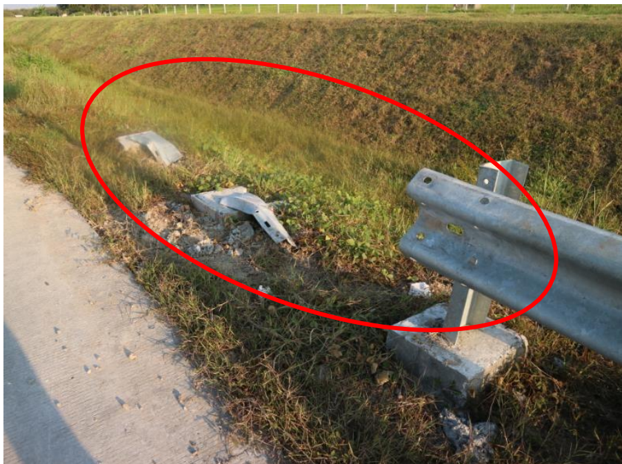
Gambar 17. Guardrail sepanjang 4 meter tertabrak mopen B-43-KKO
