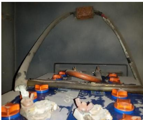
Gambar 5. Ditemukan korosi akibat luapan air ACCU dan kondisi terminal yang korosi
