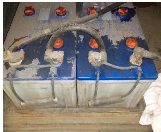
Gambar 5. Ditemukan korosi akibat luapan air ACCU dan kondisi terminal yang korosi
