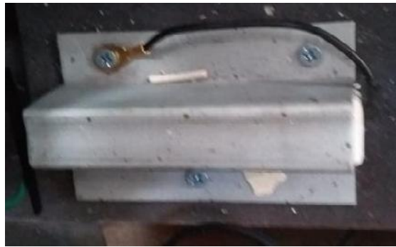
Gambar 25. Bonding pada secondary frame
