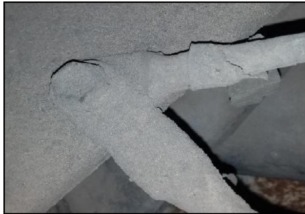
Gambar 15. Penumpukkan ground stud
