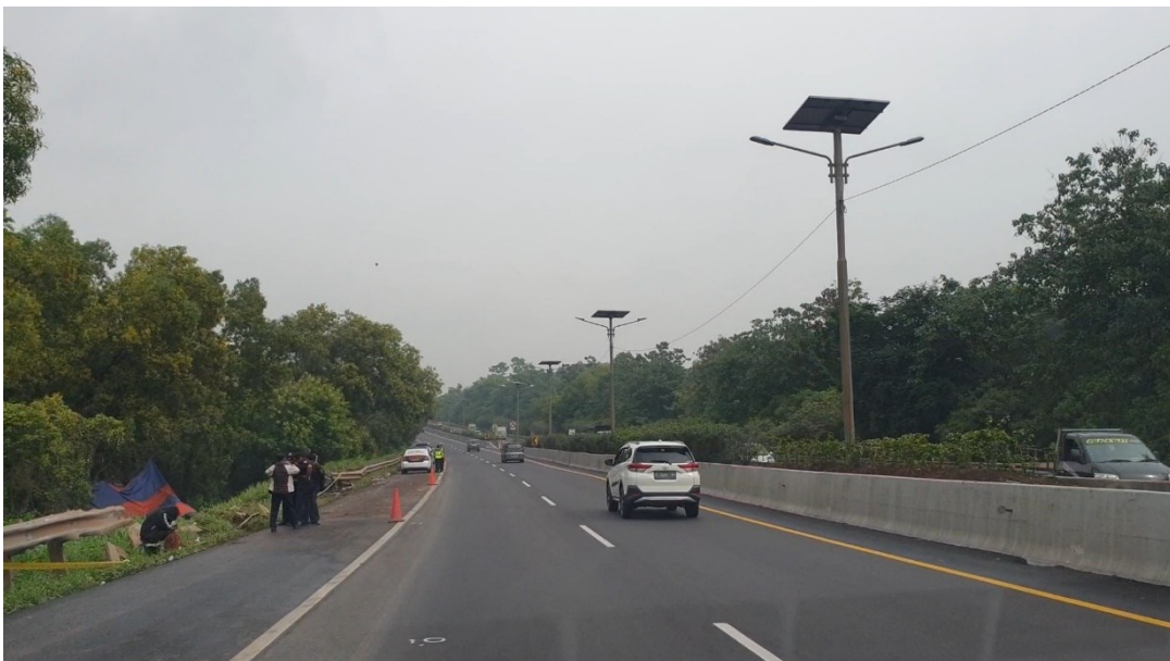
Gambar 3. Lokasi Kejadian Kecelakaan
