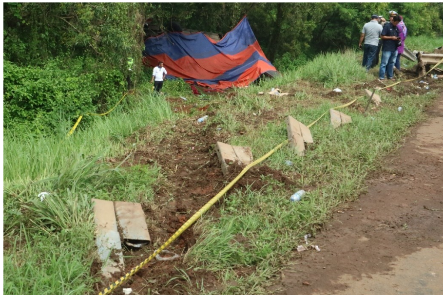
Gambar 17. Tiang Penyangga Pagar Pengaman Roboh
