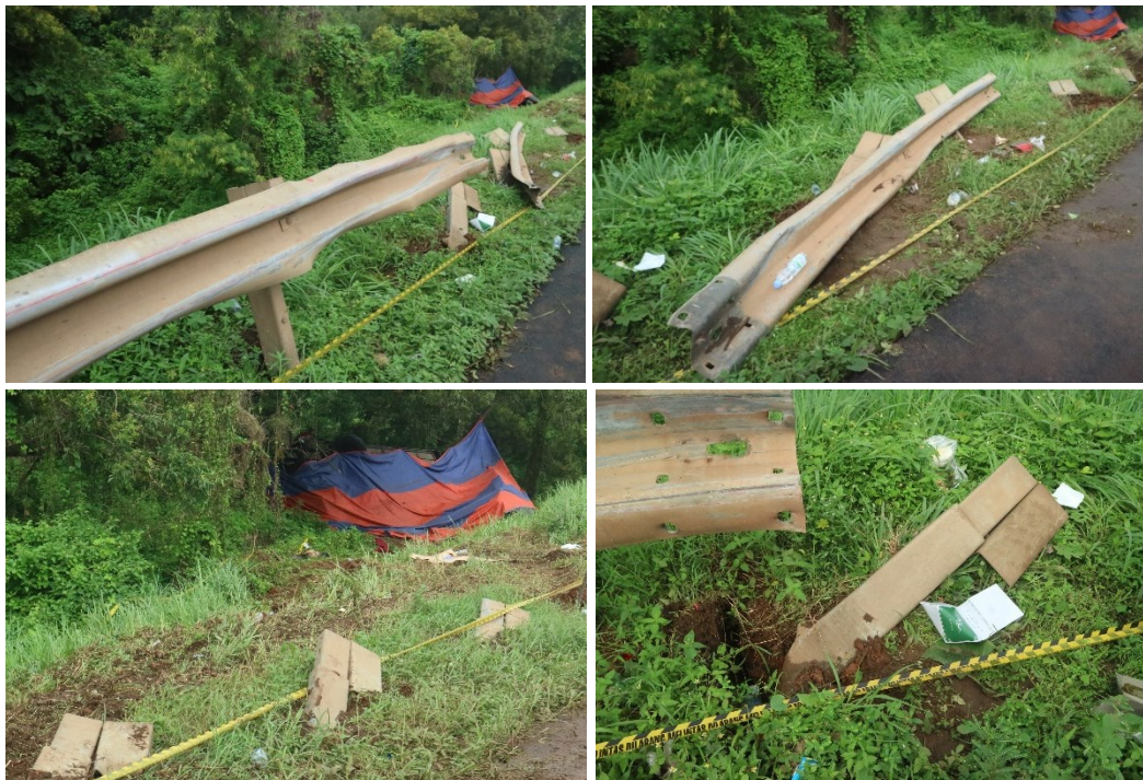
Gambar 6. Kerusakan Guardrail
