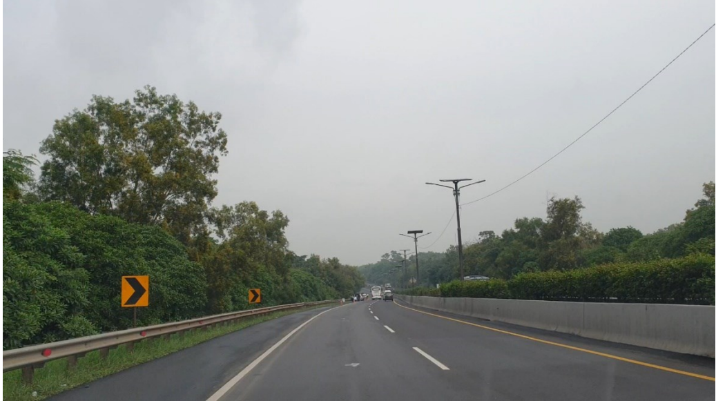
Gambar 12. Kondisi Ruas Jalan sekitar 150 Meter Dari Lokasi Kejadian
