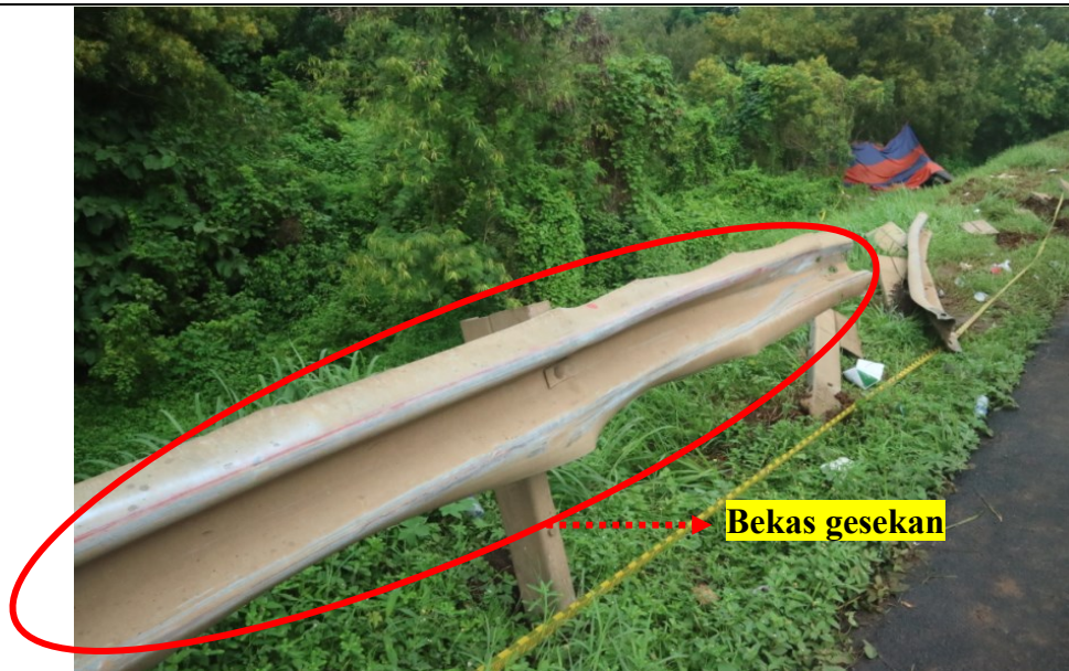
Gambar 15. Bekas Gesekan Badan Mobil Bus Dengan Pagar Pengaman
