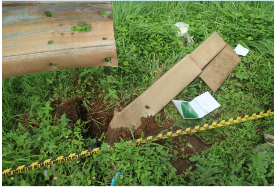
Gambar 16. Komponen Pagar Pengaman Terlepas
