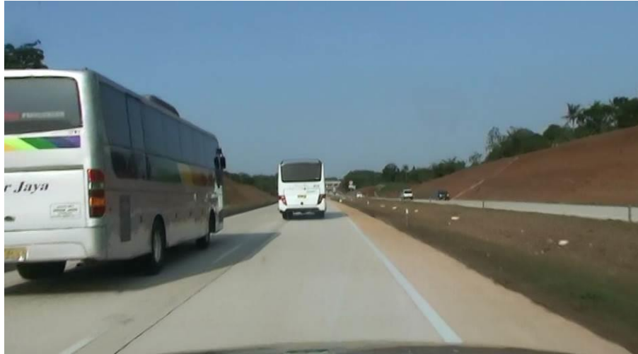
Gambar 27. Posisi kendaraan yang menghalangi pandangan pengemudi untuk melihat sisi kiri jalan.
