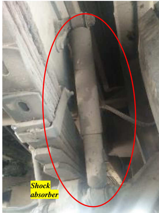
Gambar 23. Pemeriksaan shock absorber menunjukkan tidak ada rembesan minyak hidrolik.
