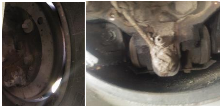
Gambar 19. Pengecekan silinder rem roda kiri depan menunjukkan tidak ada kebocoran minyak hidrolik.
