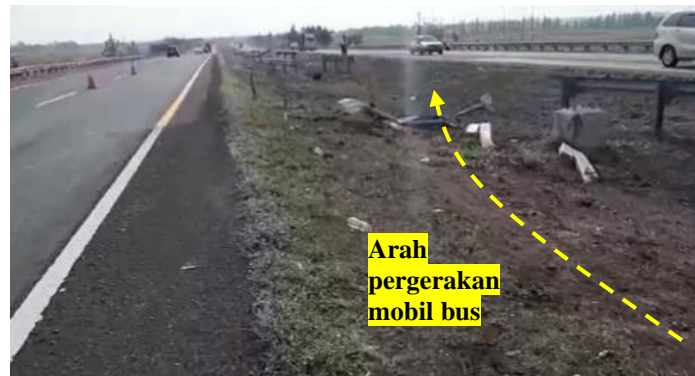
Gambar 8. Pergerakan mobil bus SJ setelah menabrak guardrail .
