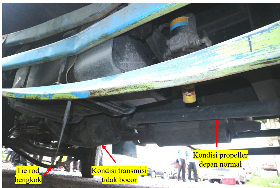
Gambar 7. Kondisi bagian bawah truk tronton arah depan
