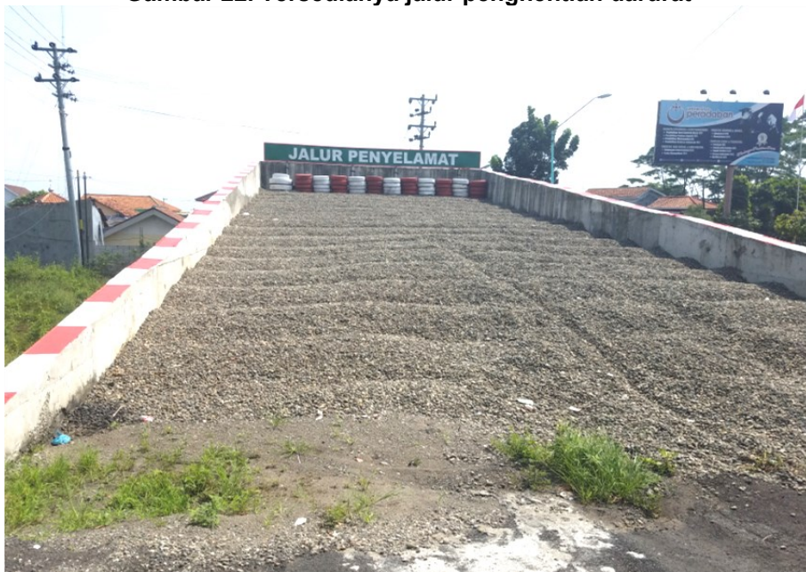
Gambar 23. Desain jalur penghentian darurat dan material tahanan laju
