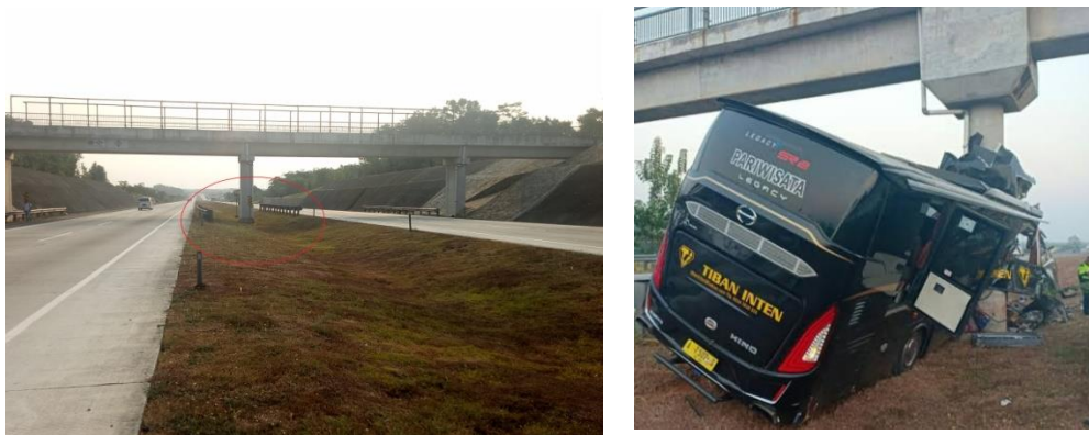
Gambar 8. Kondisi sebelum dan sesudah tubrukan
