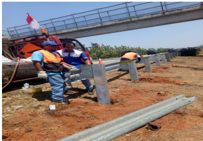
Gambar 7. Pagar Pengaman Jalan yang langsung diperbaiki
