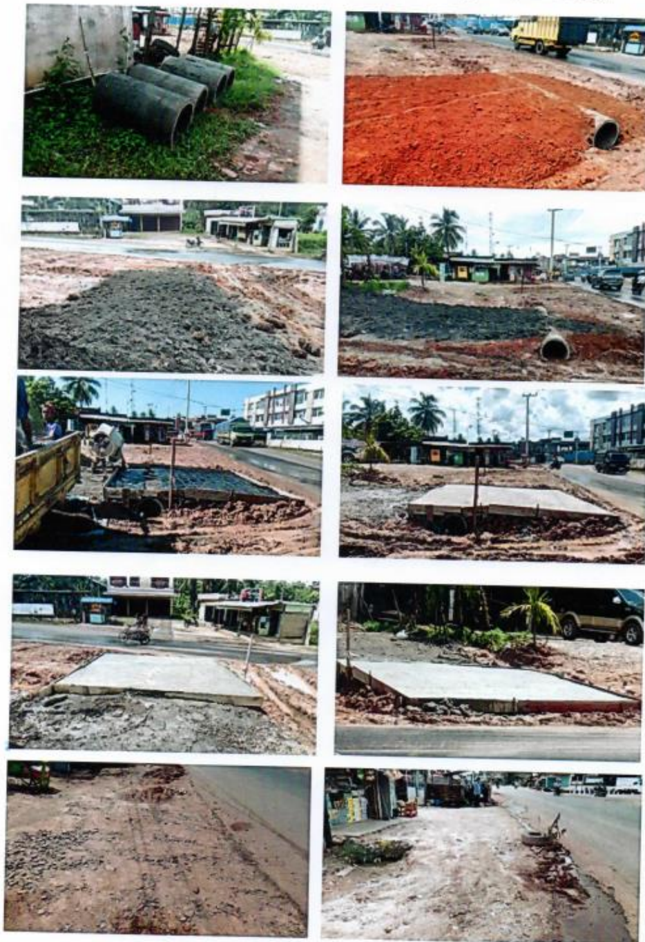
Proses normalisasi pasca pekerjaan pemasangan pipa gas selesai dilakukan
