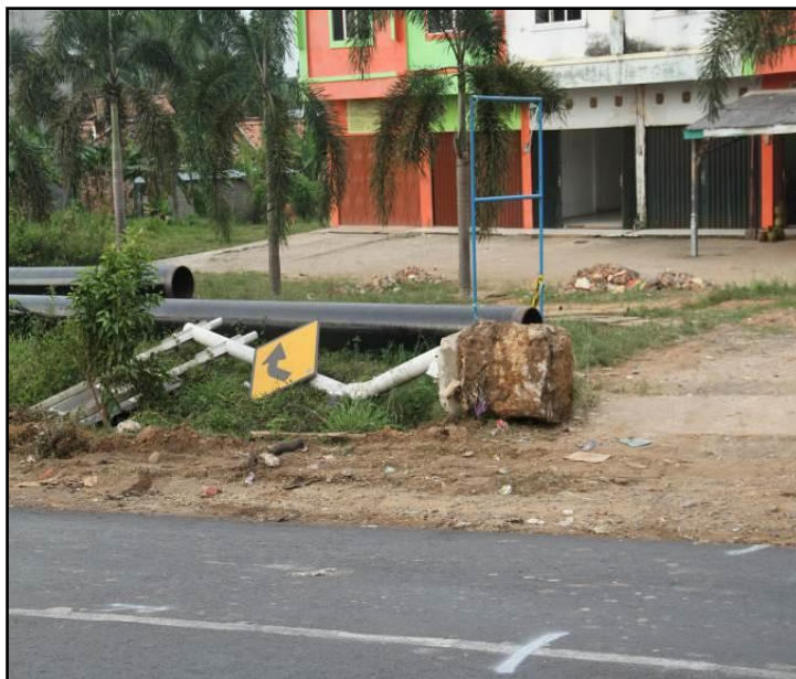
Gambar 21. Rambu peringatan yang roboh dan rusak setelah tertabrak mobil bus.
