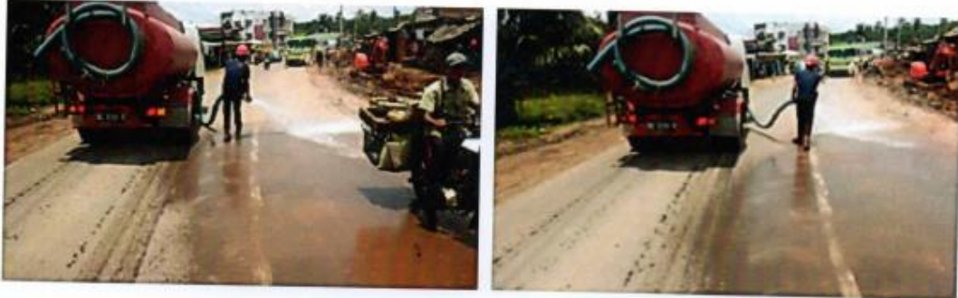
Proses pembersihan jalan yang kotor dan licin terkena tanah secara berkala sehingga tidak membahayakan pengguna jalan dengan melakukan penyiraman menggunakan truk air
