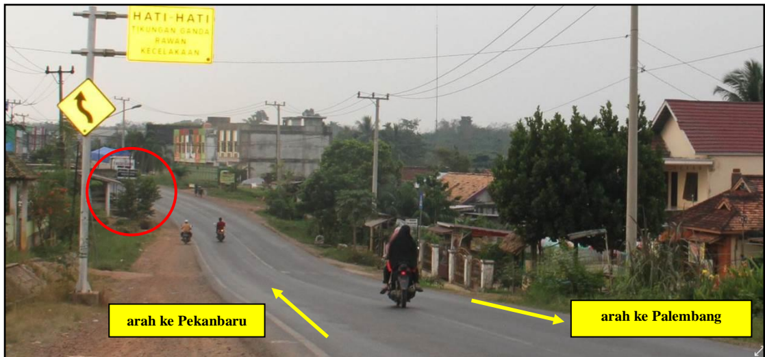
Gambar 42. Pohon dan bangunan yang menghalangi jarak pandang pengemudi.
