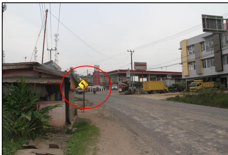
Gambar 40. Tinggi rambu peringatan tikungan ke kiri kurang memenuhi standar yang ditentukan
