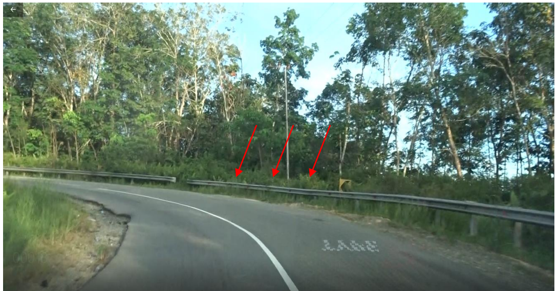
Gambar 12 Guardrail Sebelum lokasi kejadian
