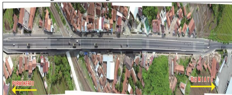
Gambar 5 Foto Flyover Kretek dari Udara
