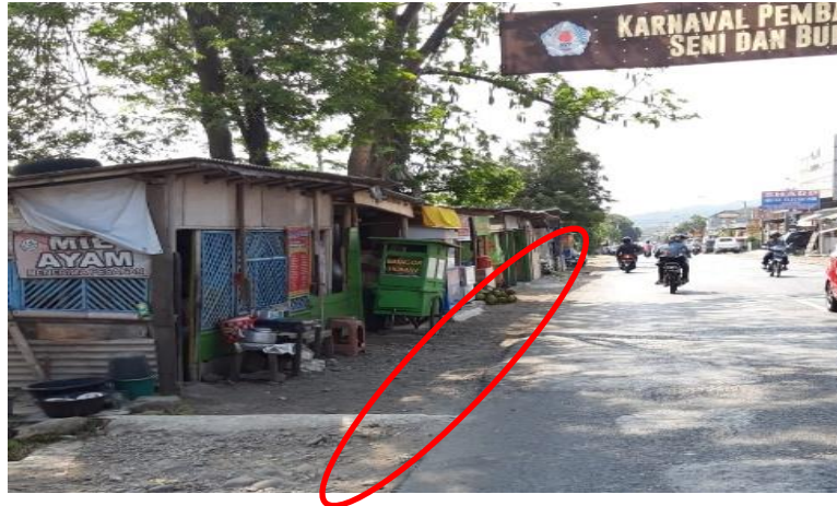
Gambar 10 Bangunan sementara yang Memakan Bahu Jalan
